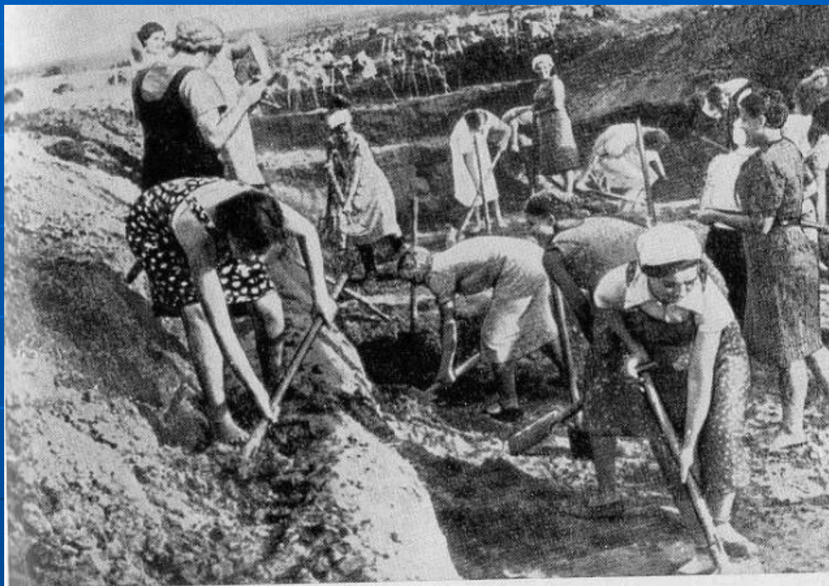
Ленинградки на строительстве оборонительных укреплений. Июль 1941 г.
