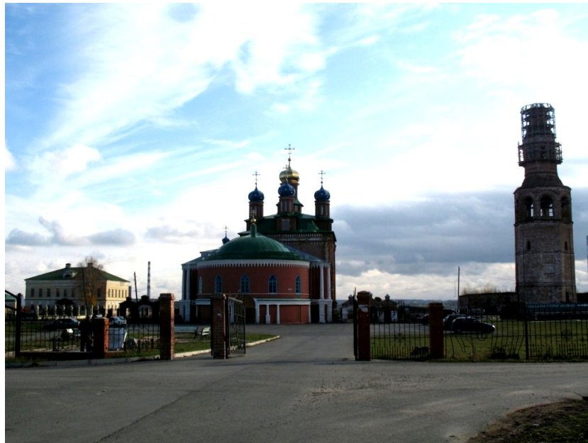
Архитектурный комплекс Усоля: дом-усадьба князей Голицыных, Спасо-Преображенский собор, соборная колокольня
