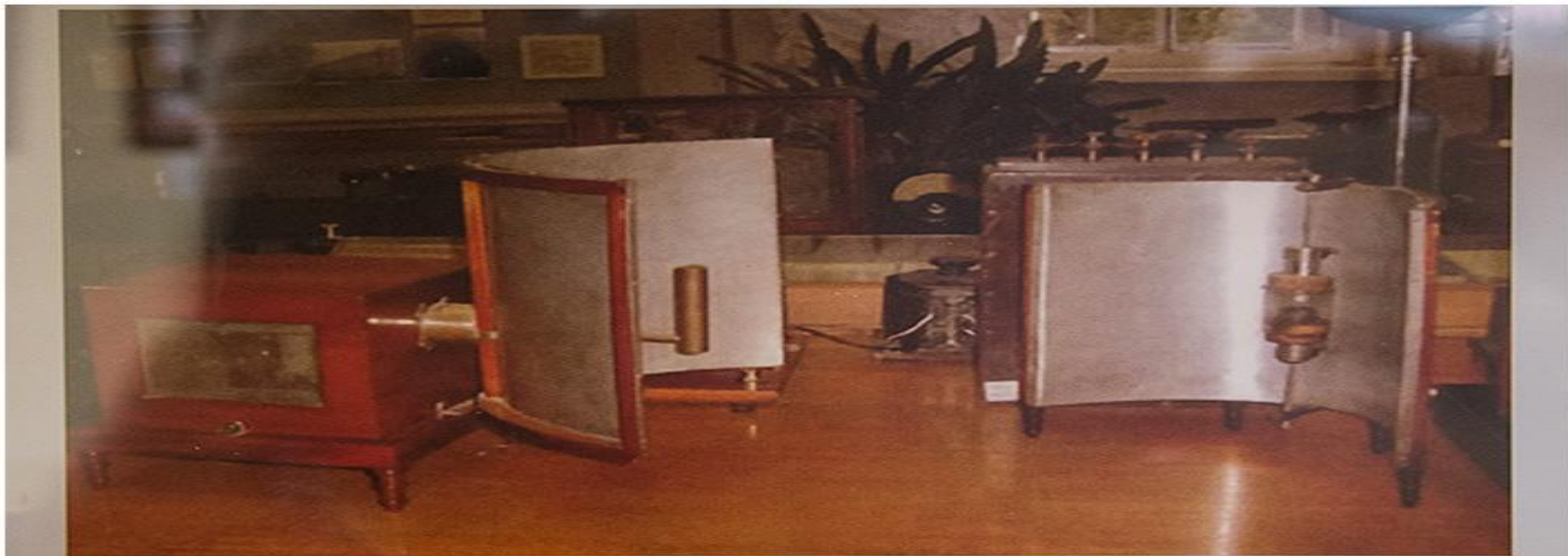
Передатчик и приёмник Попова с направленными антеннами, с помощью которых 12 (24) марта 1896 г. была передана первая в мире радиотелеграмма «Heinrich Hertz» на расстояние 250 м.
