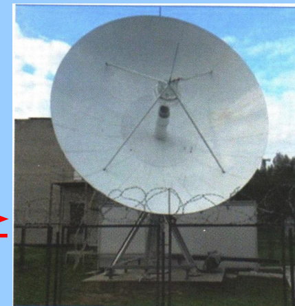
Необслуживаемая наземная станция КИС
