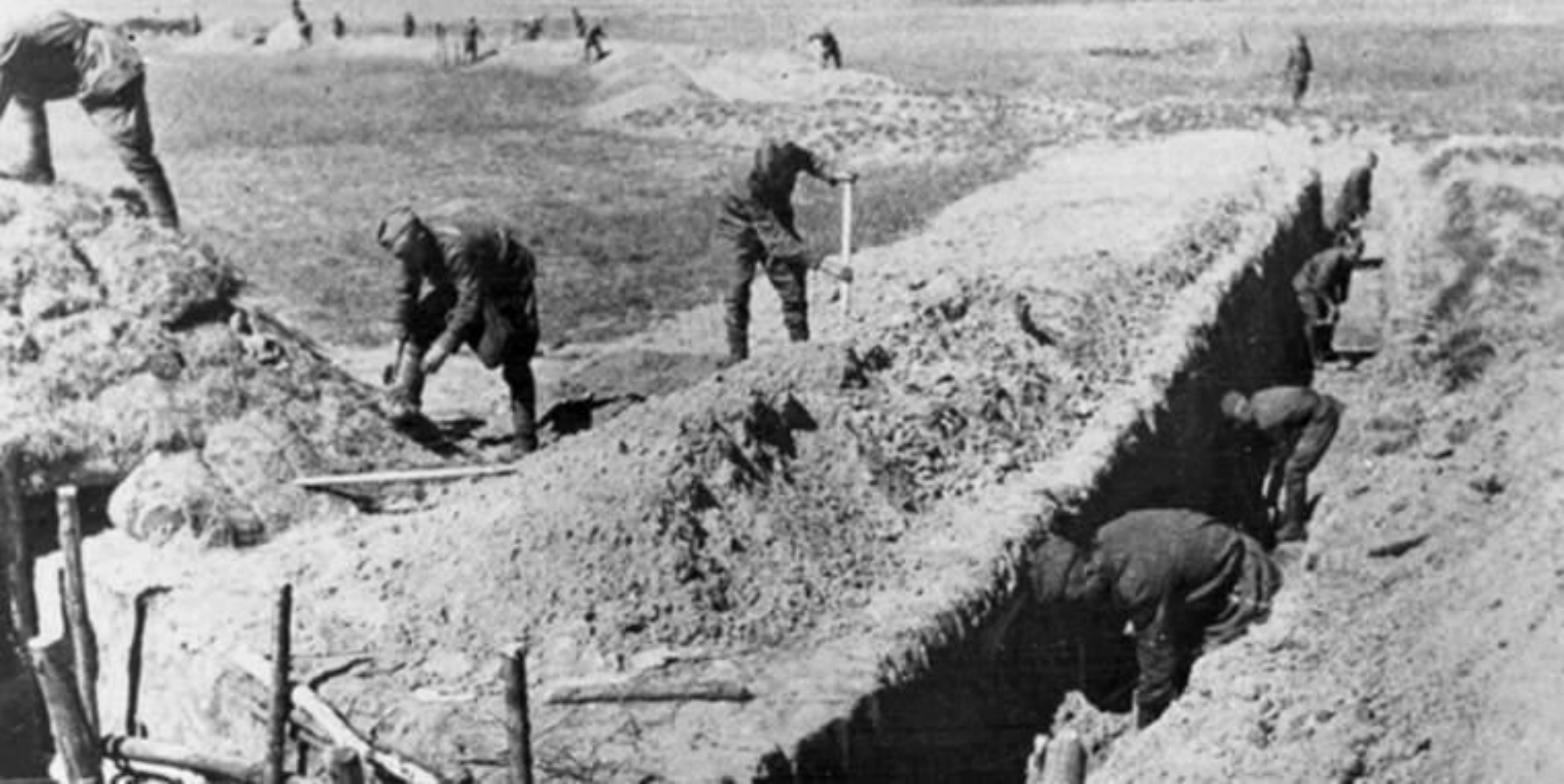
Строительство оборонительных сооружений на Курской дуге
