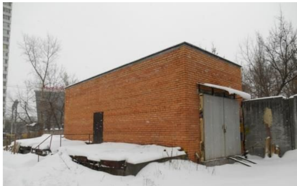
Очистные (незавершенное строительство)
