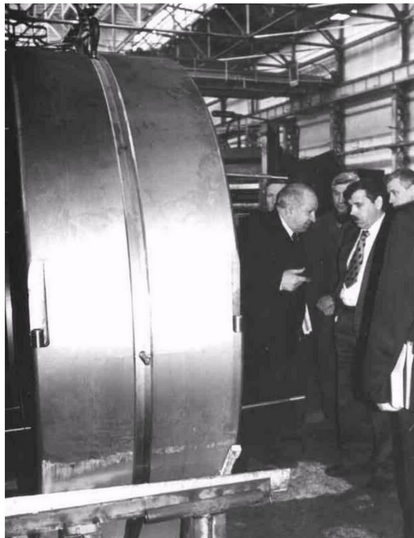
Подшипник 230К.64 для опоры вертикального конвертера АО "Северсталь" 91
