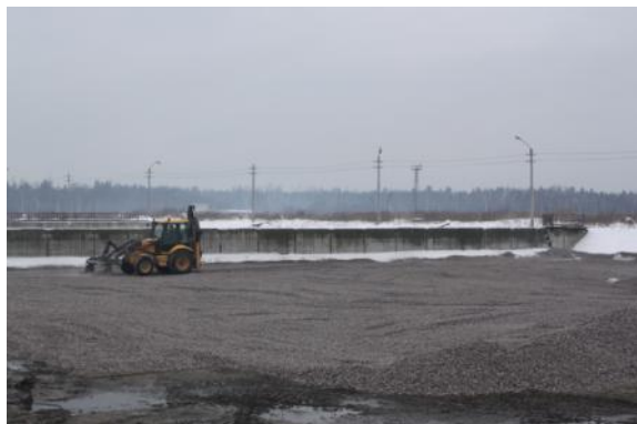
Отсыпка подушка из щебня
