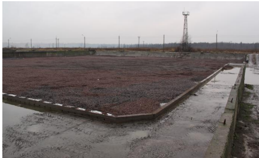
Подготовленный дренаж для укладки геотуб
