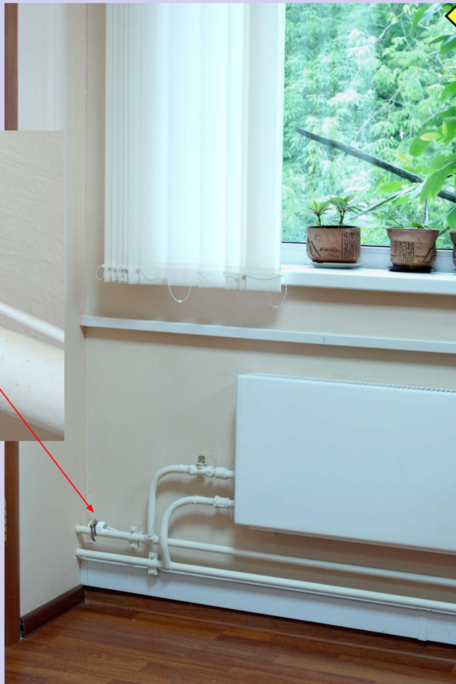
Схема установки вибризлучателя на трубе
