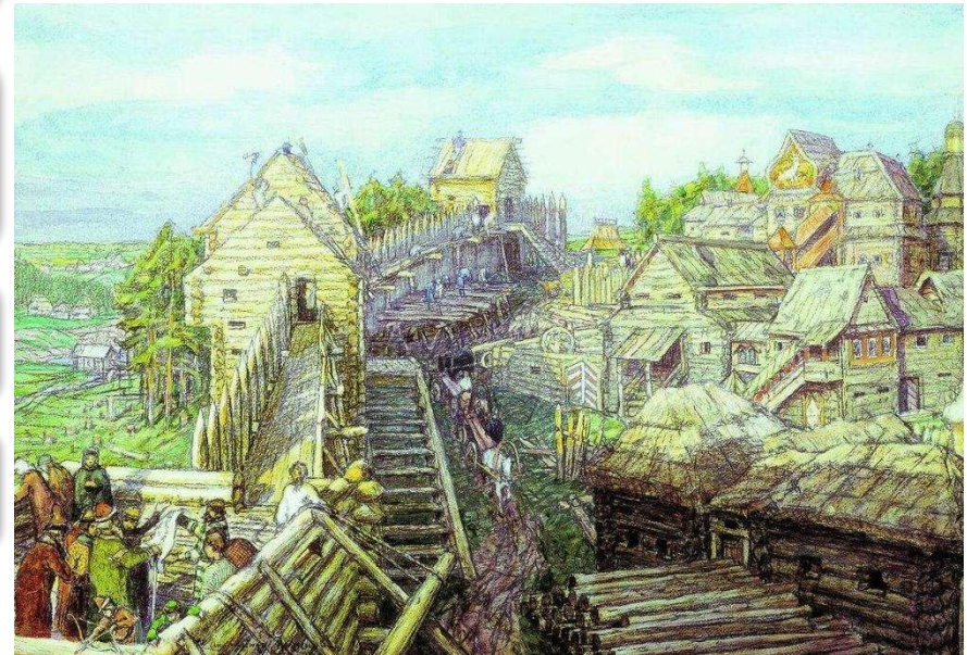
Строительство деревянных стен кремля. XII век художник А.М. Васнецов
