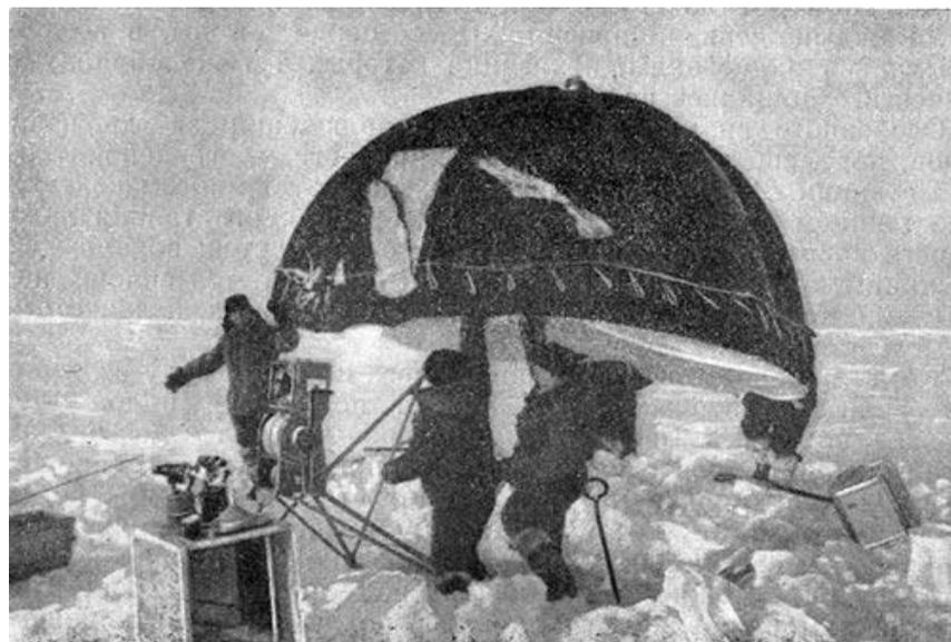
Рис.5 Установка гидрологической палатки на «СП – 2»
