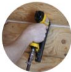
УКЛАДКА И КРЕПЛЕНИЕ ШНУРА
