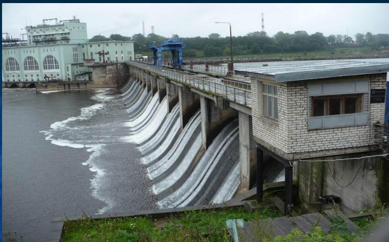
ГЭС г. Волхов
