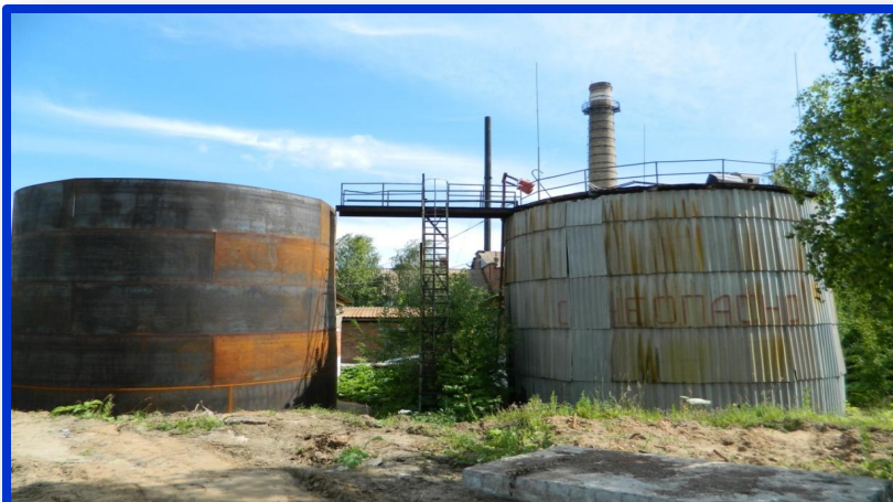
РЕЗЕРВУАРЫ ДЛЯ ХРАНЕНИЯ МАЗУТА
