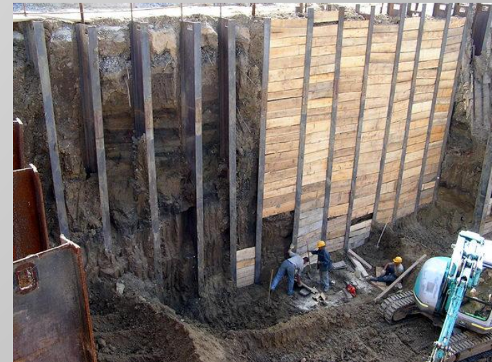
Схема крепления котлована с помощью двутавровых балок
