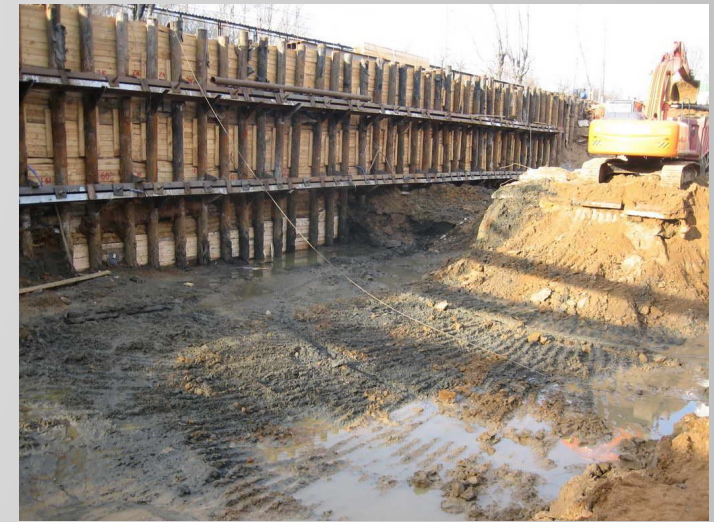
Схема крепления котлована с помощью стальных труб
