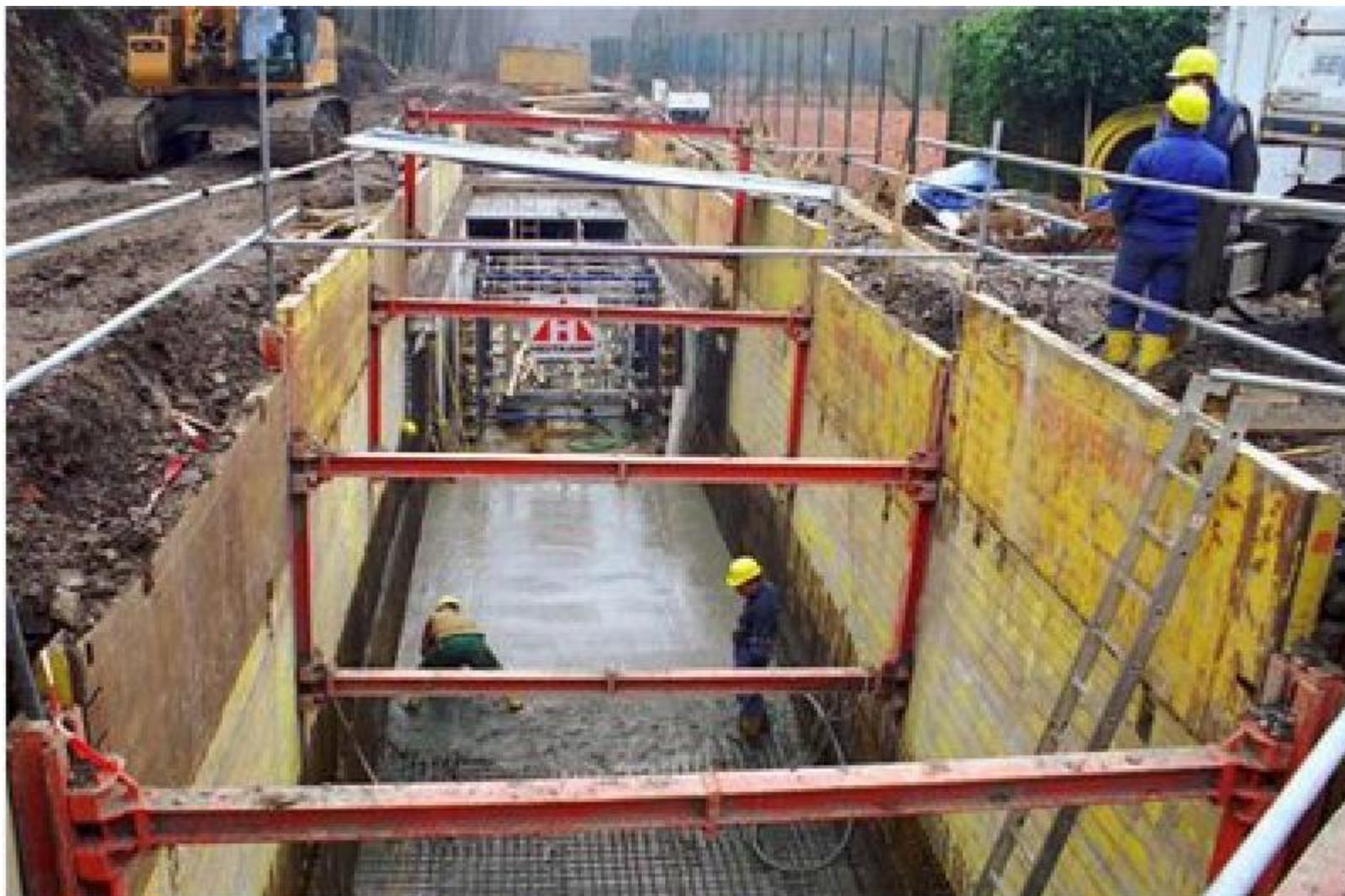
**Извлекаемое закрепление стенок траншеи из щитов и распоров (расстрелов)**
