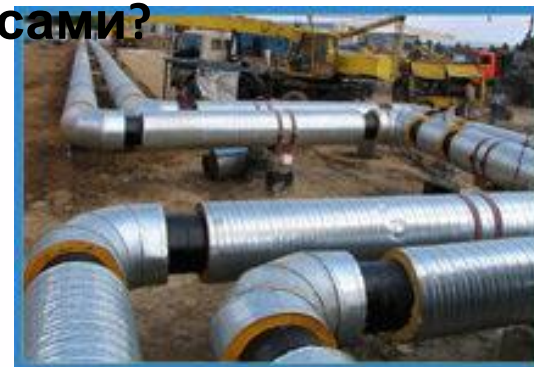
монтаж компенсаторов
