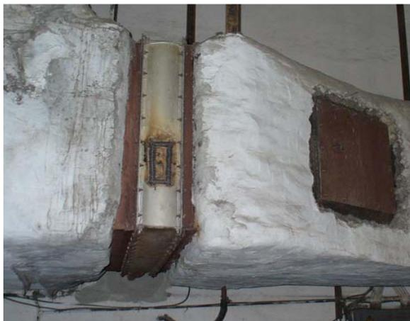
Экспериментальная установка теплообменника-утилизатора за паровым котлом №3 в котельной ЭПК УрФУ.
