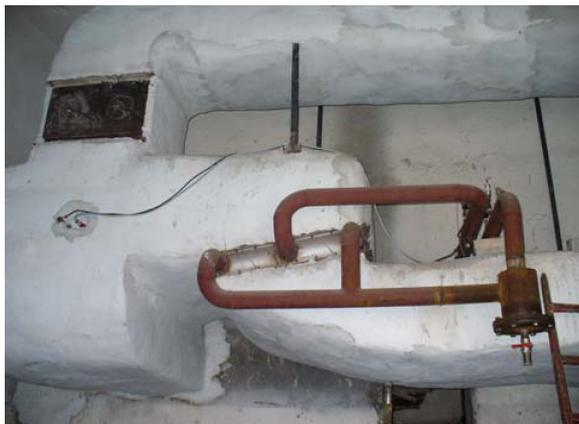
Экспериментальная установка теплообменника-утилизатора за паровым котлом №1 в котельной ЭПК УрФУ.
