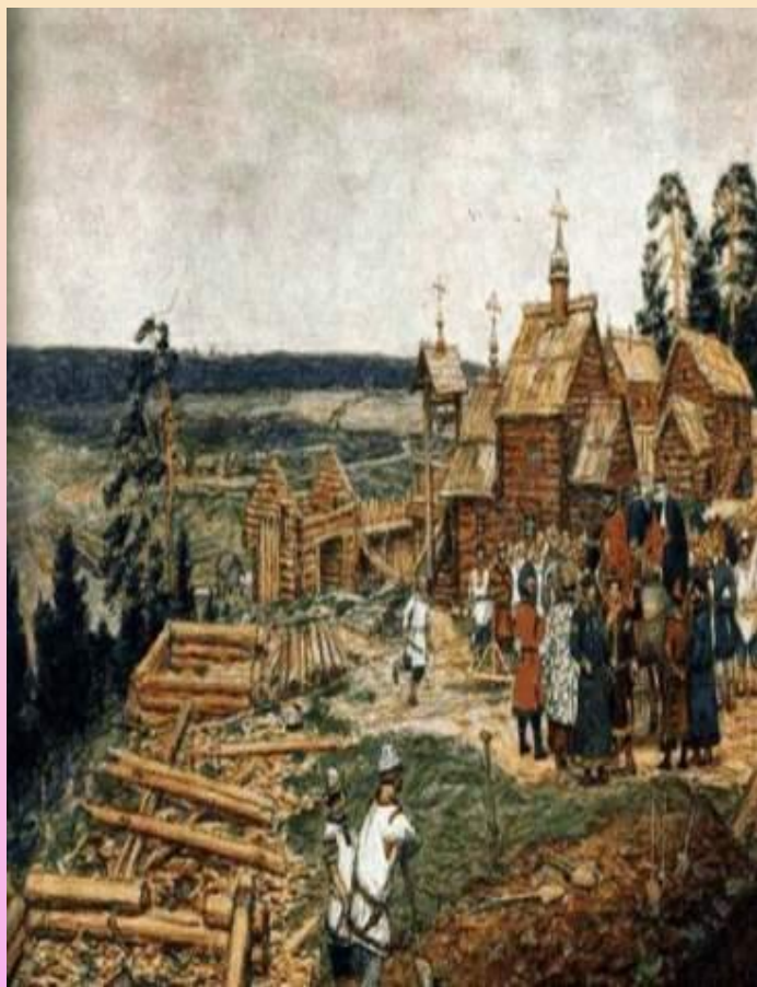
Строительство деревянного Кремля
