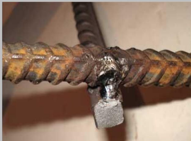
Рис.11 Сварка арматуры
