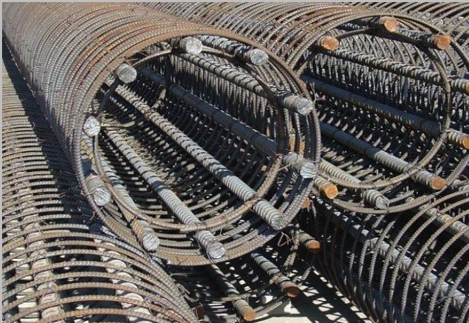
Рис.10 Пространственная вязка
