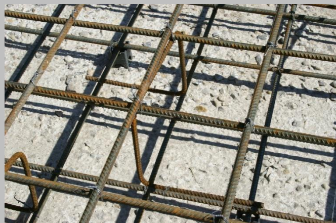
Рис.13 Вязка при помощи проволоки
