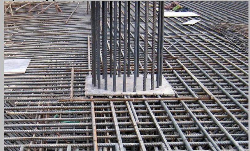
Рис4. Каркас из арматуры
