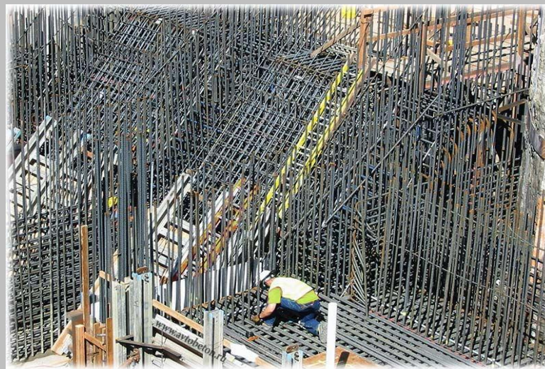
Рис.8 Распределительная арматура
