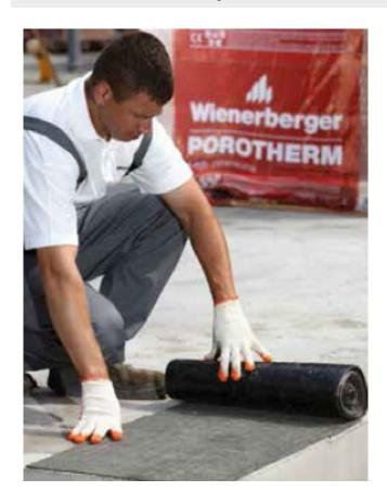
Первый ряд блоков укладывается на слой рулонной гидроизоляции, которая на 10 см шире, чем блок
