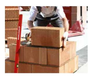
Кладка начинается с углового кирпича, который укладывается непосредственно в слой кладочного.
