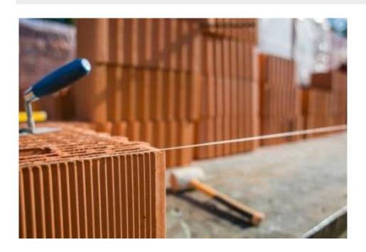
Образовавшиеся таким образом «угловые точки» соединяются по верхней кромке камней с помощью натянутого шнура для кирпичной кладки (нейлон). Шнур свободно натягивается по всей длине.
