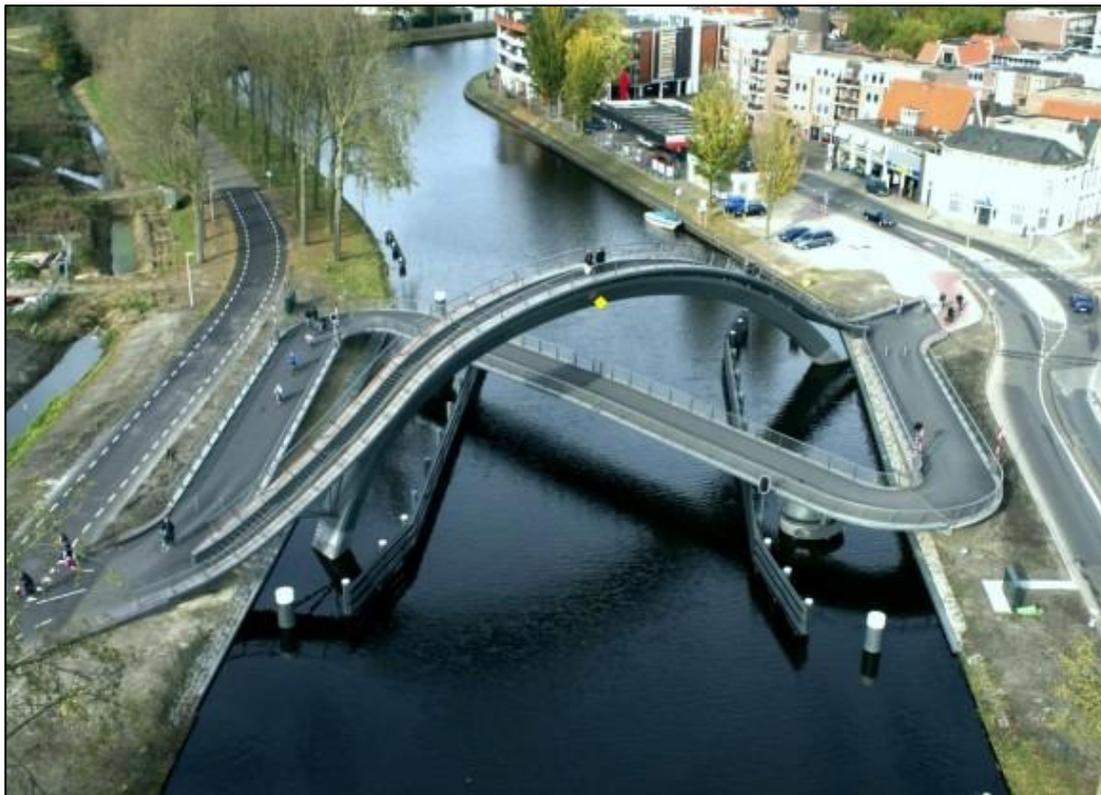
Мост соединяет исторический центр города Пурмеренде с новым районом и состоит из двух секций. Нижняя горизонтальная часть моста, предназначена в основном для велосипедистов и инвалидных колясок
