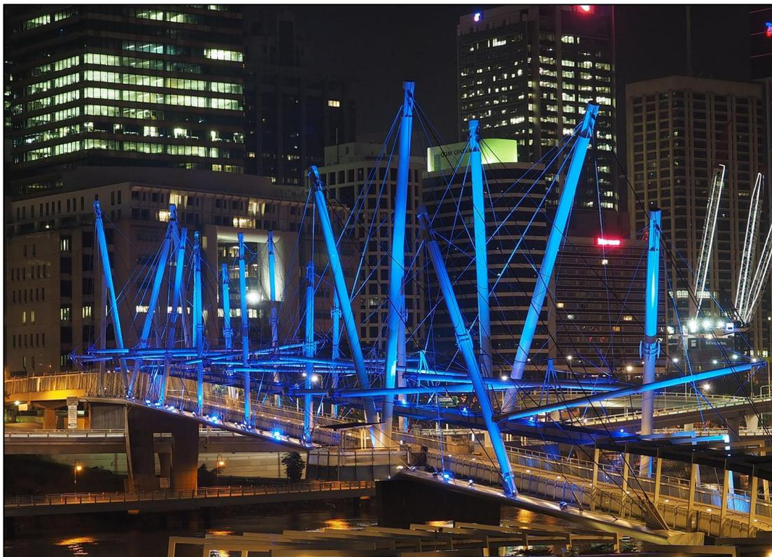
Принцип «тенсегрити» или принцип самонапряженных конструкций, основан на использовании элементов, работающих только на сжатие или только на растяжение. В дождливую погоду мост питается от городской электросети. Помимо пешеходов на мост допускаются ещё и велосипедисты. На Курилпе есть два оборудованных места отдыха и защищающий от солнца навес, протянутый по всей длине моста. Интересен также пандус, обеспечивающий нужный уклон для захода пешеходов, въезда велосипедистов на мост.
