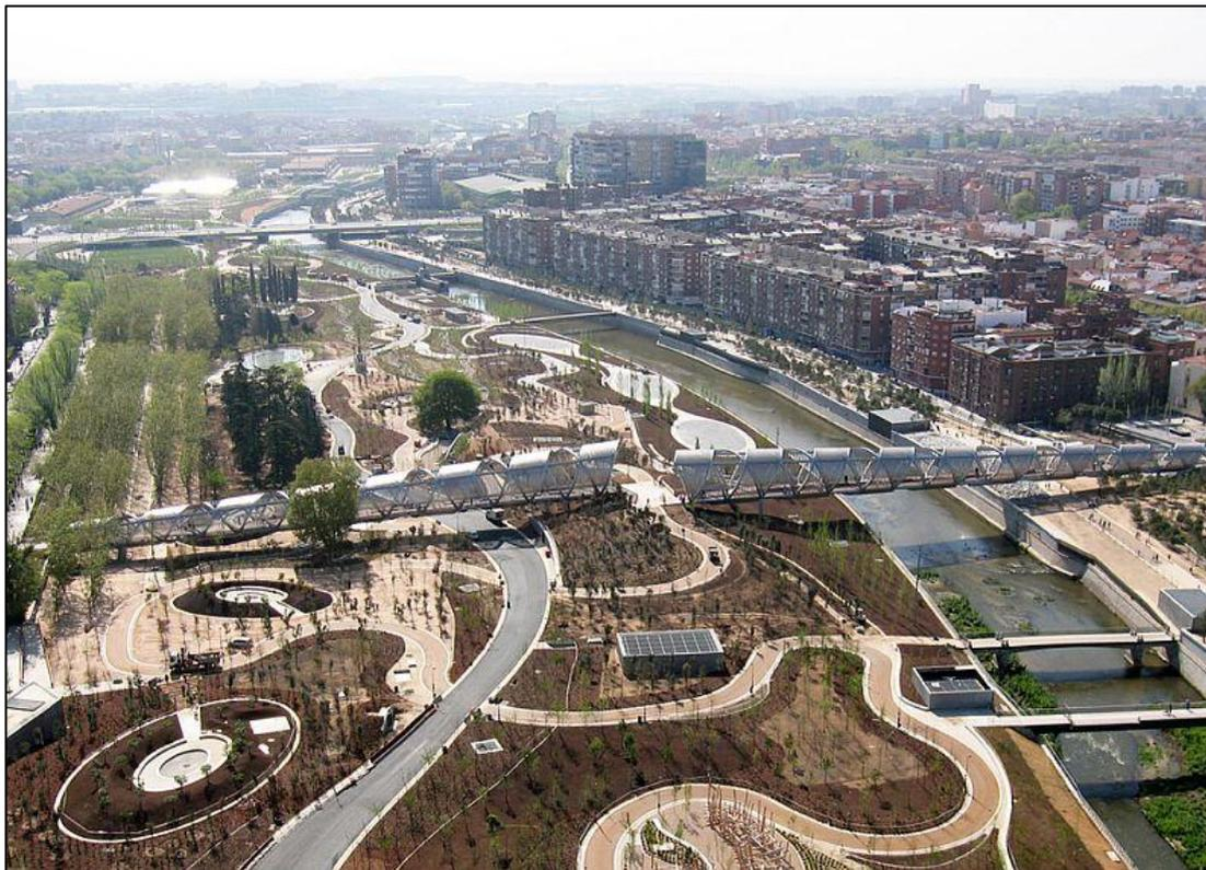
Мост состоит из двух частей длиной, соответственно, 150 и 128 метров, выполненных в виде конусообразных труб, причем эти трубы являют собой навитые в виде спирали конструкции, разделяющие мост на секции, в одних из которых видны плоские ребра, а в других - металлическая сетка. Так как мост проходит через два парка, то стояла задача создать такую конструкцию, чтобы она, с одной стороны не затеняла парки, а с другой - давала необходимую тень и защиту от ветра внутри моста.
