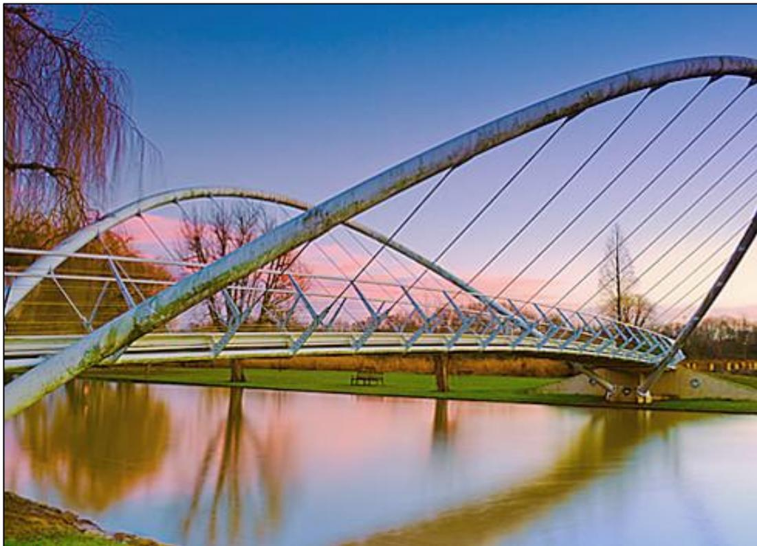
Этот мост переброшен через реку Уз в английском городе Бедфорде в 1997 году. Арки наклонены подобно крыльям бабочки, что и дало название мосту. Максимальный размах двух стальных арок составляет 32 метра, что создает впечатление объемности моста и открытости его прохожей части небу. Мост способствовал возрождению речной набережной и стал новой достопримечательностью города. Установленное на арках освещение придает мосту по вечерам сказочный вид.
