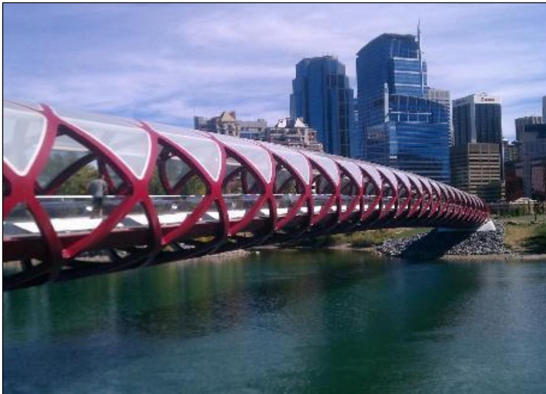
Длина моста 135 м, ширина 6,2 м. Яркий трубчатый стальной мост со стеклянным покрытием для защиты от зимних осадков, но достаточно открытый, чтобы сохранить прохладу летом. Мост получился полностью погруженным в естественный ландшафт и пропитанным уважением к окружающей среде. Однопролетный вариант без промежуточных опор был выбран, исходя из экологических соображений, чтобы не подвергать реку загрязнению в ходе строительства.
