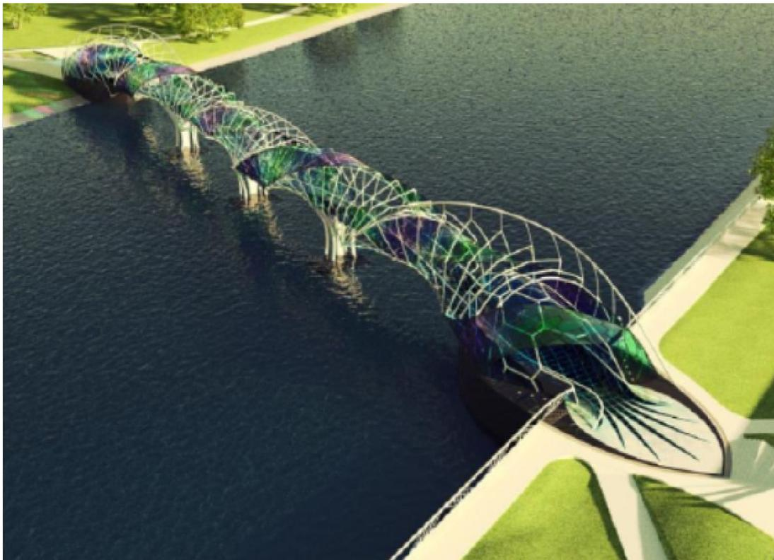
Конструкция моста имеет сложную формообразующую закономерность, воспроизводящую спиральную пластичность молекулы ДНК. Важным приемом является спиральная закономерность не только в элементах и внешней каркасной оболочке, но и в транзитной поверхности моста, которая изменяет свое положение и угол наклона по ходу спирали
