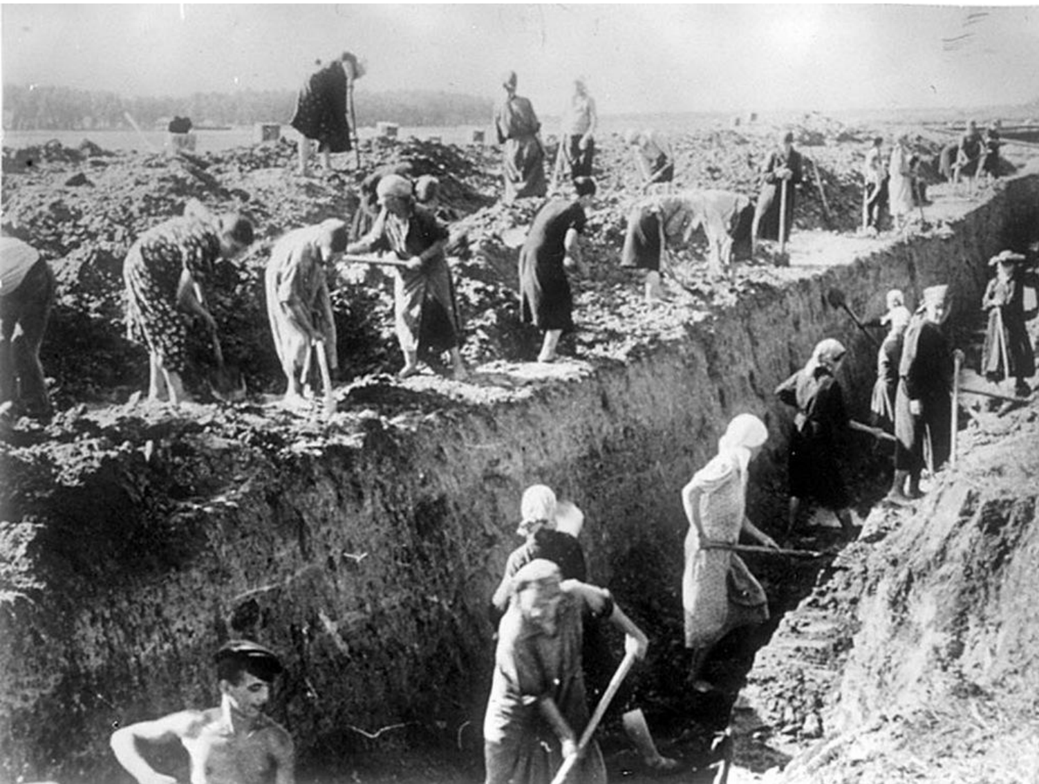
Жительницы прифронтовых деревень на строительстве оборонительных сооружений. Июль 1941 г.
