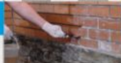
Очистка и защита фасадов от высолов, гидрофобизация
