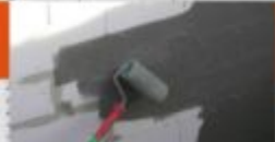
Защита цоколя мастичной гидроизоляцией
