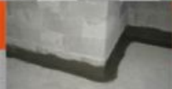
Устройство гидроизоляции изнутри
