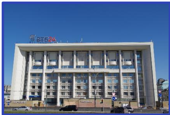
Гидроизоляция технических помещений здания банка ВТБ
