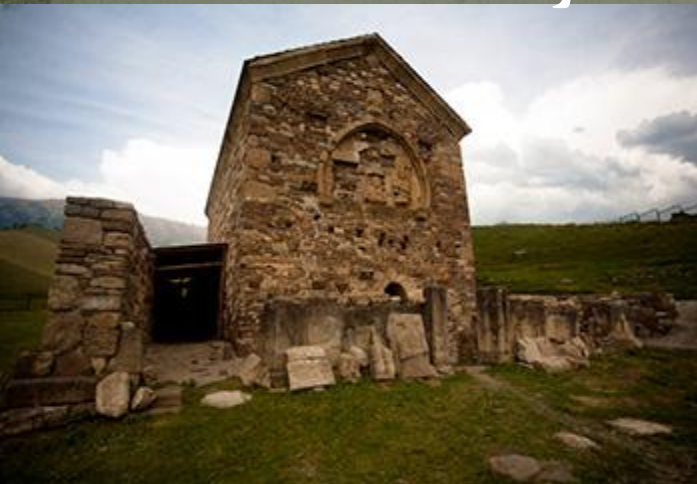
Разрушенное здание в Зимовейской станице. Наше время.
