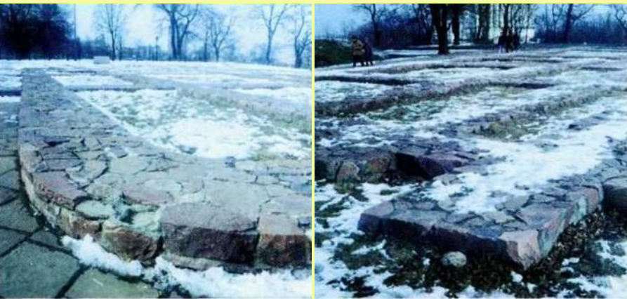
Фундаменты Десятинной церкви
