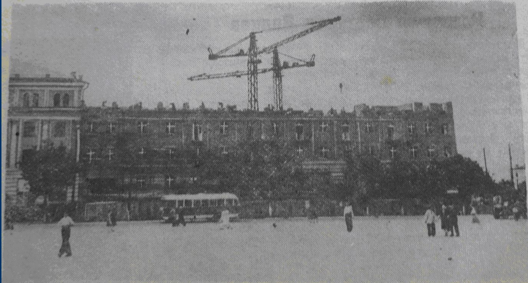
Строительство здания центрального универмага
