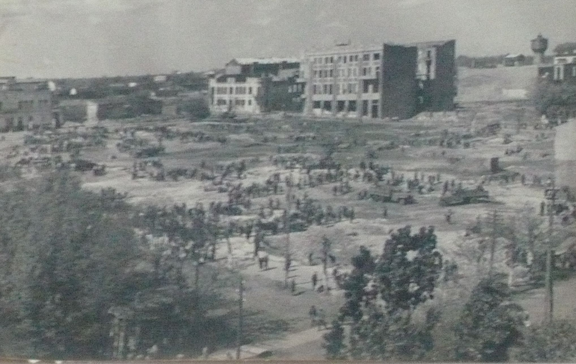
Восстановительные работы в городе Армавире после освобождения от немецко-фашистской оккупации
