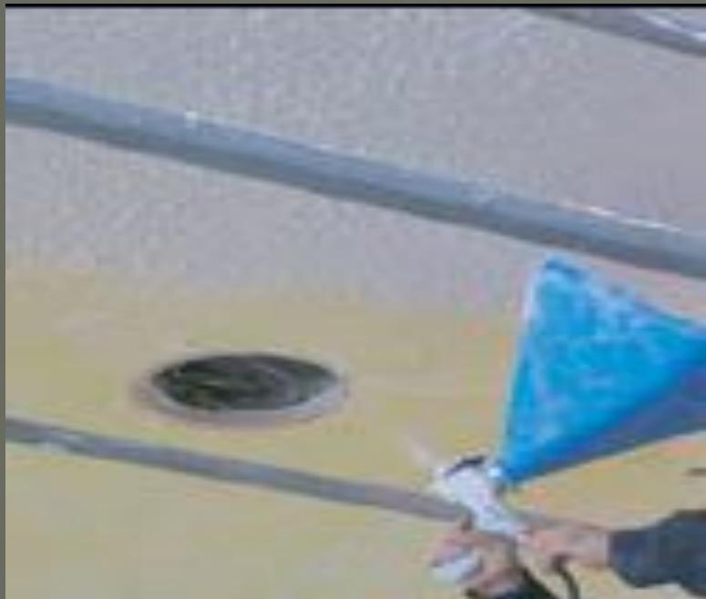
Напыление акустической штукатурки
