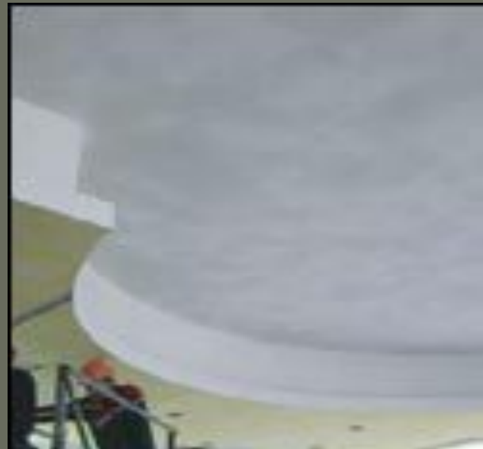
Поверхность покрытия в процессе высыхания
