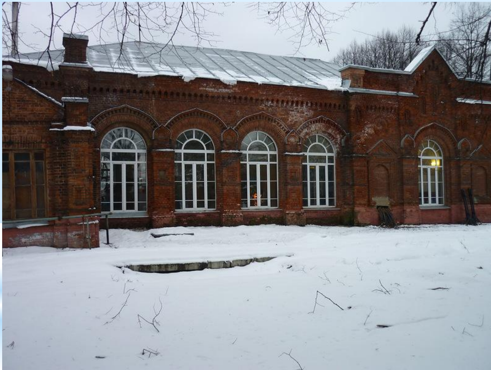
Мытищинская водопроводная станция
