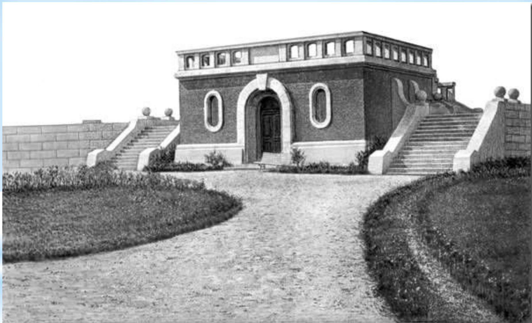
Московские водопроводы, Рублевская насосная станция. Отводящая камера английск. фильтровъ.
