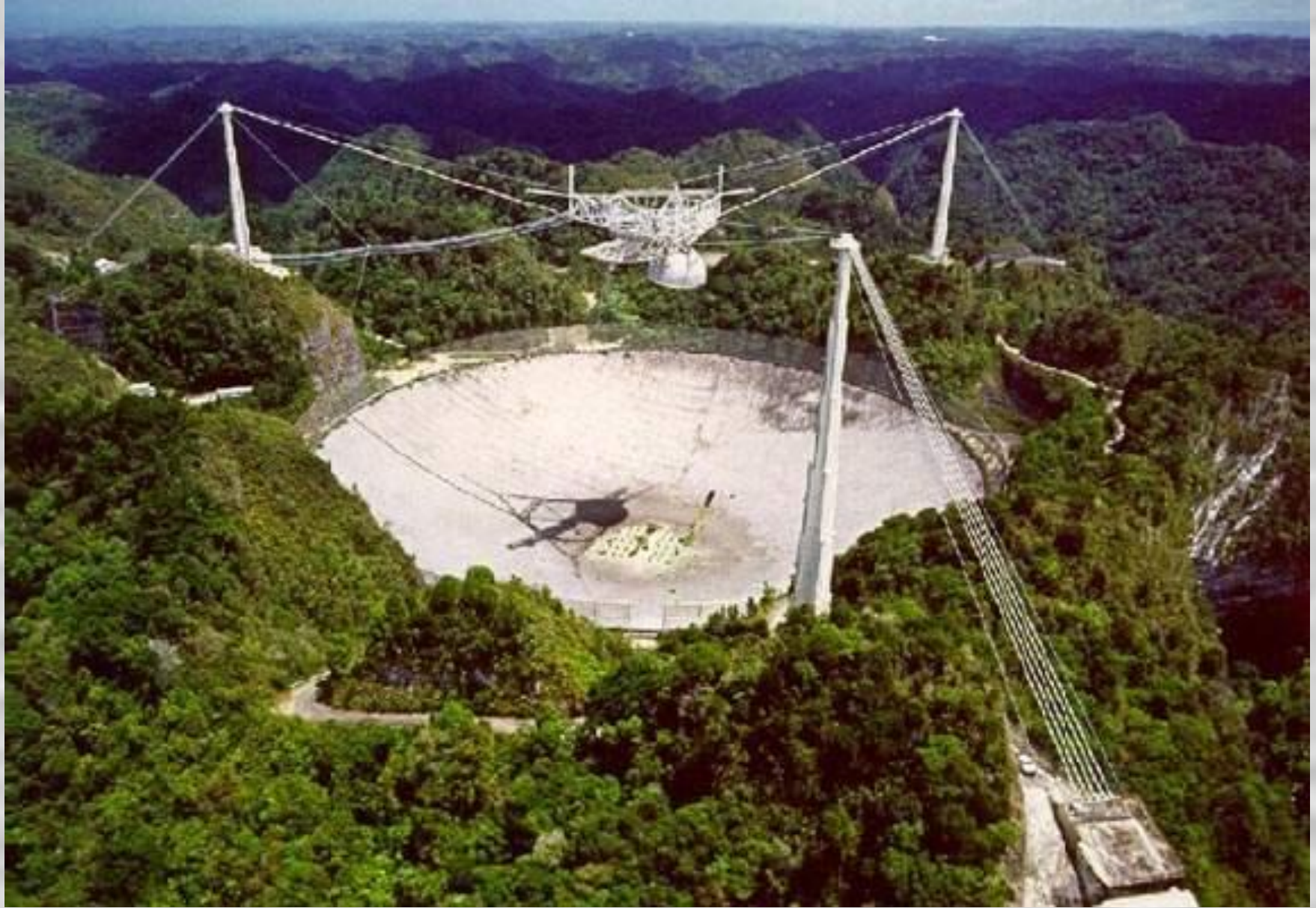
Аресибо (остров Пуэрто –Рико, 305м-забетонированная чаша потухшего вулкана, введен в 1963г). Самая большая радиоантенна в мире
