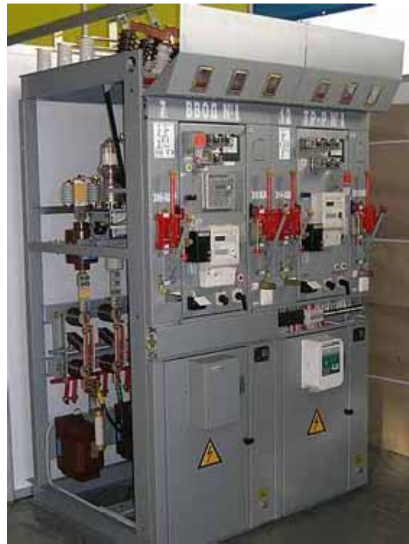
Общий вид камер КСО-2000
