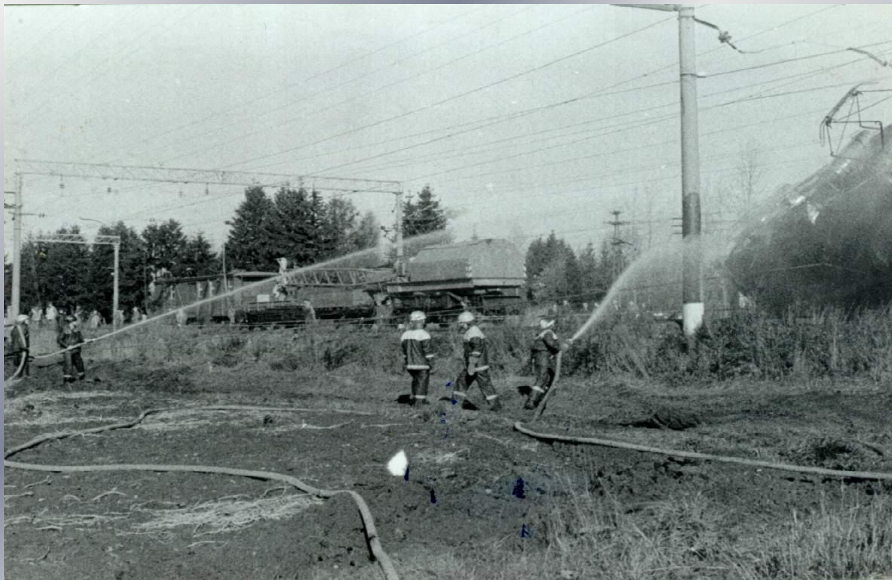
Работа пожарных по предотвращению искрообразования при разборке вагонов
