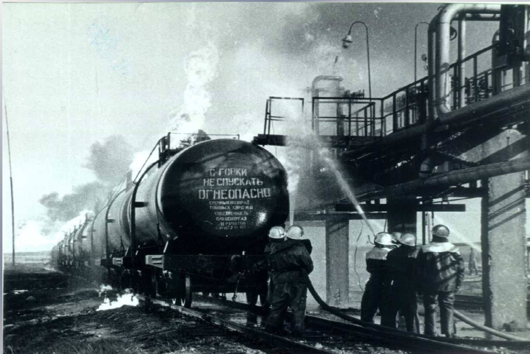
Тушение пожаров на сливной эстакаде
