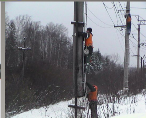
Монтаж самонесущего ВОК.
