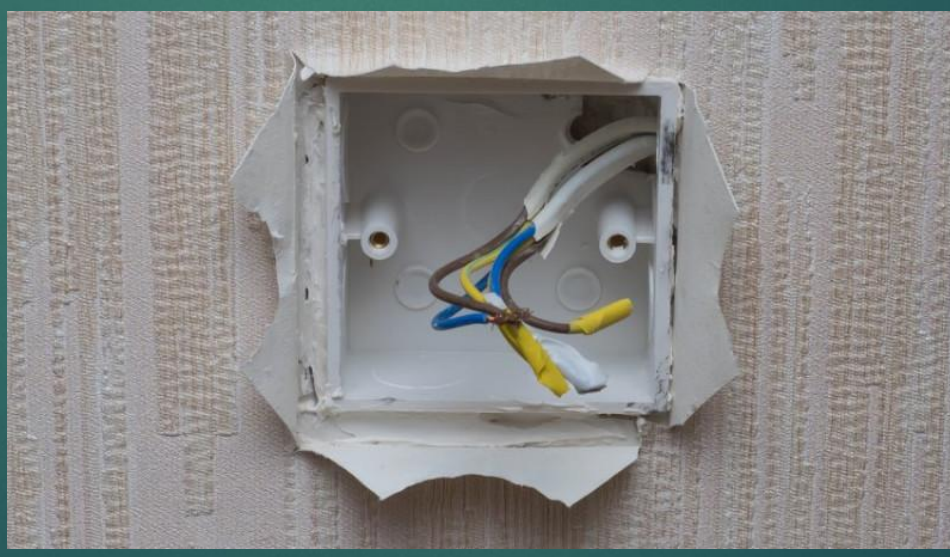
3) Устанавливаем подрозетник
