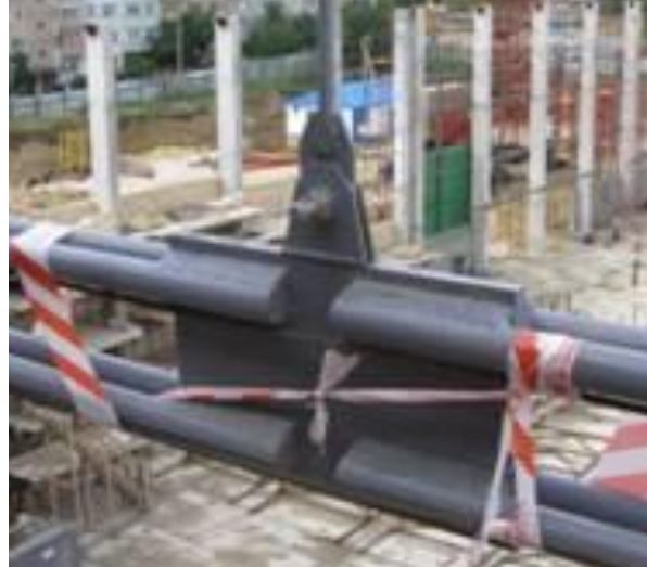
Стальная затяжка из 4 стержней и подвес
