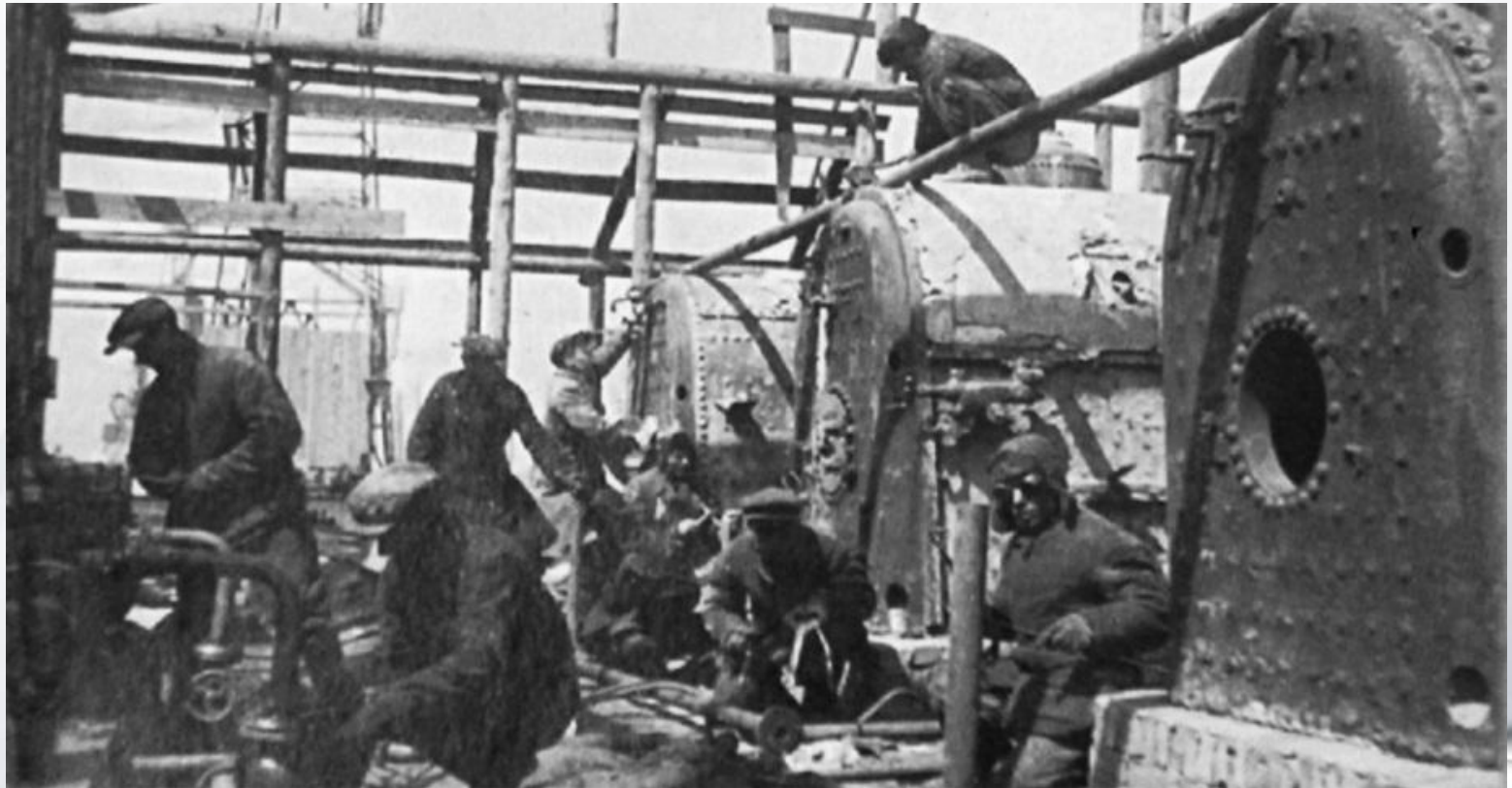
Монтаж оборудования на Сызранском нефтеперерабатывающем заводе
