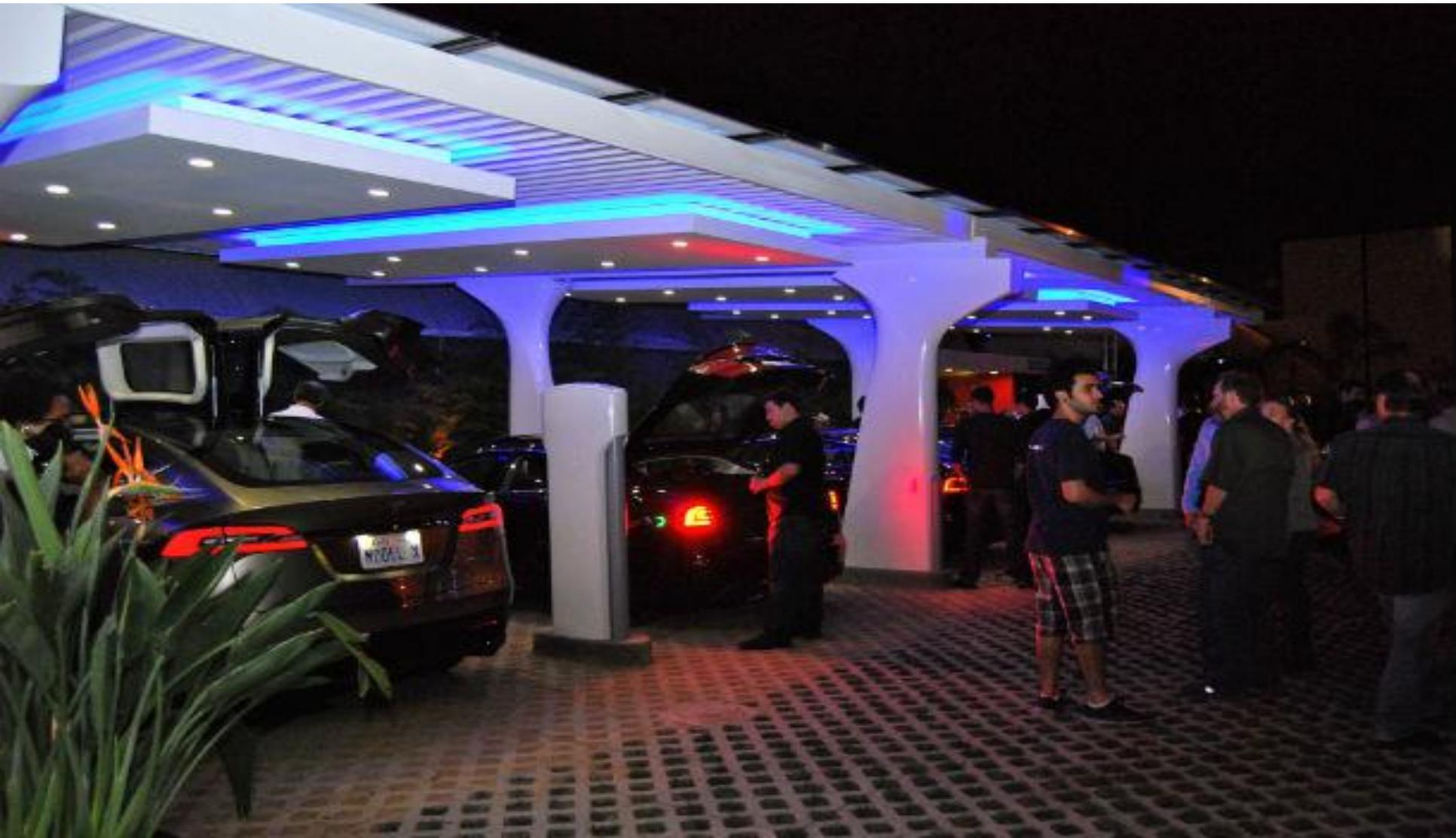
На такой «заправке» можно добрать до 320 км дальности пробега за 30 минут, а полная зарядка займет примерно час в случае батареи на 85 кВтч. Для владельцев последней спецификации зарядка полностью бесплатная.
