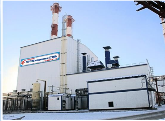
2 ГТЭС «Урал-6000», г. Соликамск ОАО «Уралкалий» Наработка: 80 975 часа
