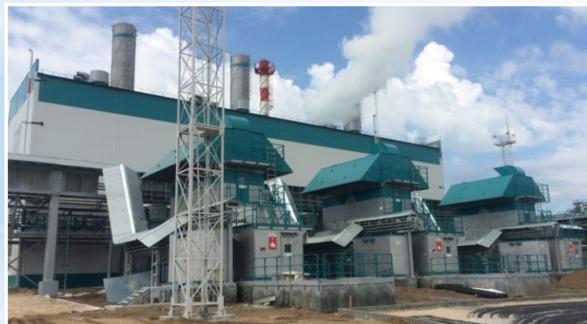
3 ГТЭС «Урал-6000» ЗАО «Сибур-Химпром» 3 КУП - ЗАО «Энергомаш», КГТ-17/1,5-250
