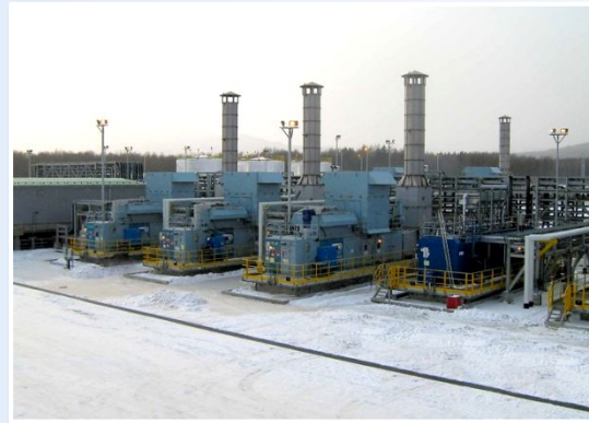
3 ГТЭС «Урал-4000», п. Гастелло Sakhalin Energy Investment Company Ltd. Наработка: 43 370 часов
