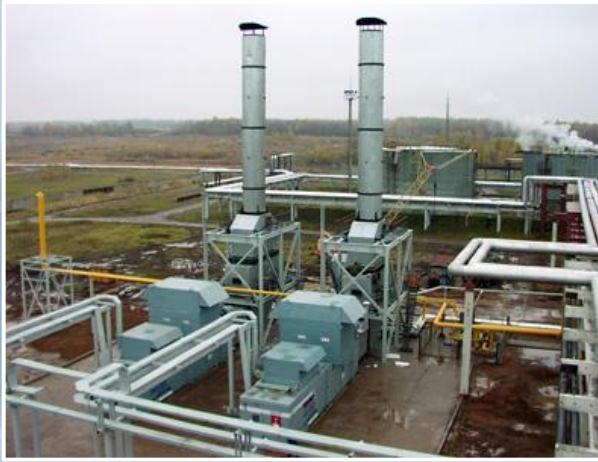
2 ГТЭС «Урал-4000», г. Агидель ООО «Башкирская генерирующая компания» Наработка: 94 140 часов
