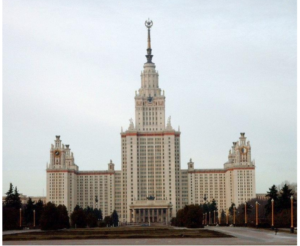
Здание Московского университета 1949—1953 годы (архитекторы Л. В. Руднев, С. Е. Чернышов, П. В. Абросимов, А. Ф. Хряков, В. Н. Насонов).
