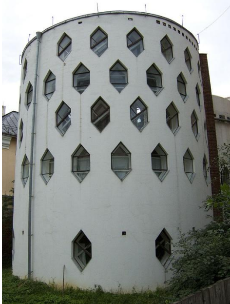
Дом архитектора Мельникова (1927 –29 е годы)
