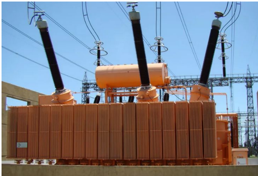
Автотрансформатор 330 кВ
