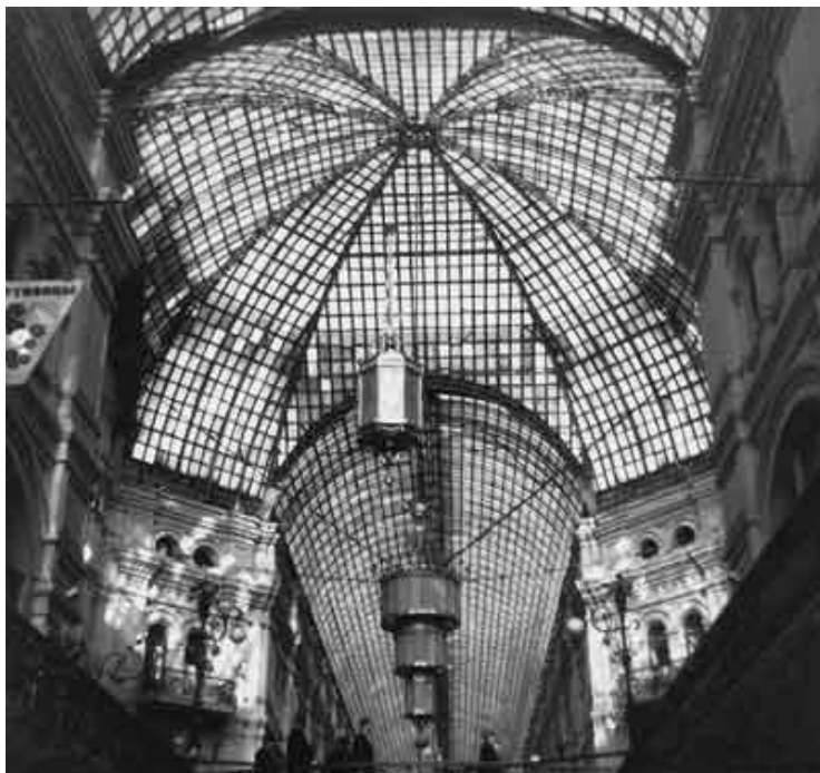
В.Г.Шухов . Металлостеклянные своды и купол перекрытия Верхних торговых рядов на Красной площади в Москве.
