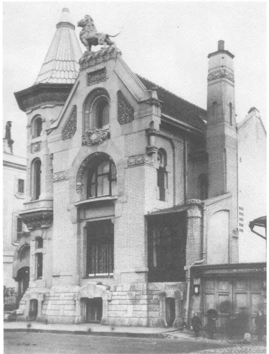
Л.Н. Кекушев. Дом Кекушева на Остоженке 21, 1901
