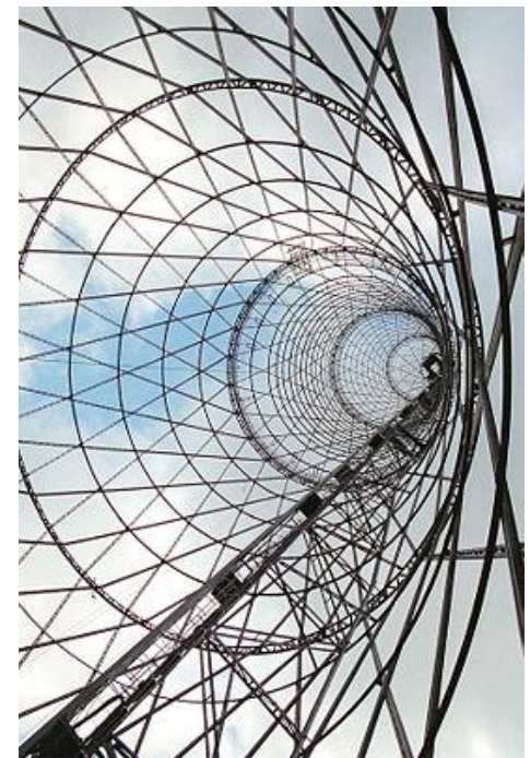
Вид башни изнутри
