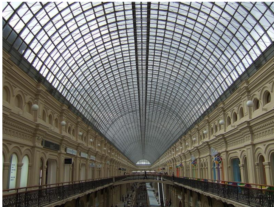
В.Г.Шухов. Конструкции арочных покрытий московских магазинов ГУМ
