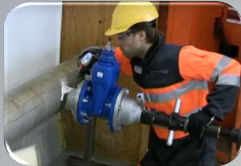
Газопровод из металлических труб
