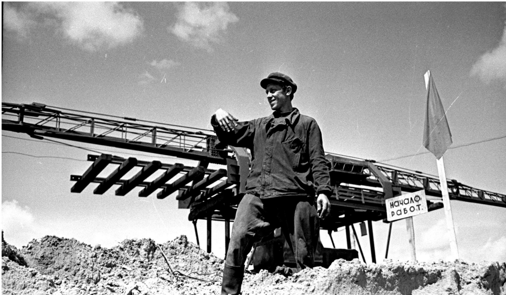
Карavaев Евгений, машинист путеукладчика на строительстве железной дороги Тюмень-Сургут
