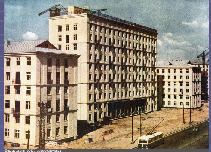
Застройка Хорошевского шоссе в Москве Каркаснопанельными домами. 1956г
