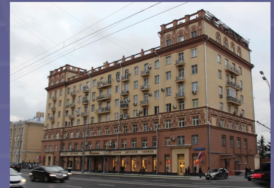
Дом на Садово-Кудринской улице 1947г. Арх К.Орлов
