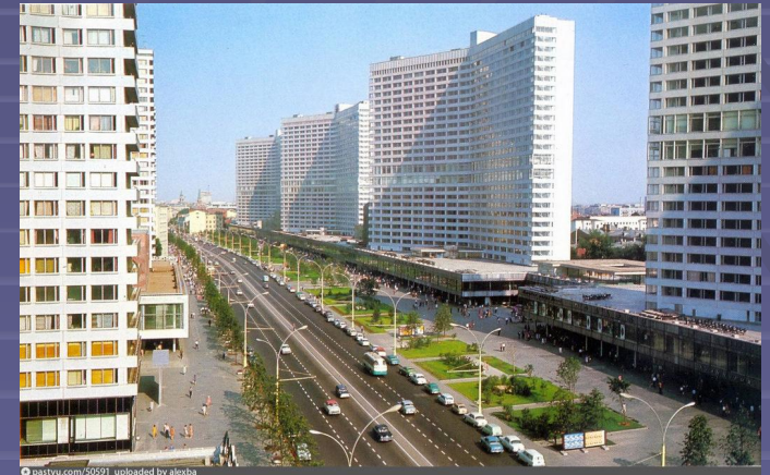
Строительство проспекта Калинина (Новый Арбат) в Москве 1962-1968г. Архитектор М.Посохин
