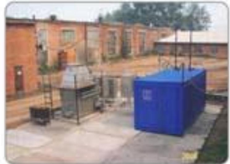
Энергокомплекс с газопоршневым электроагрегатом 100 кВт на генераторном газе из древесных отходов.
