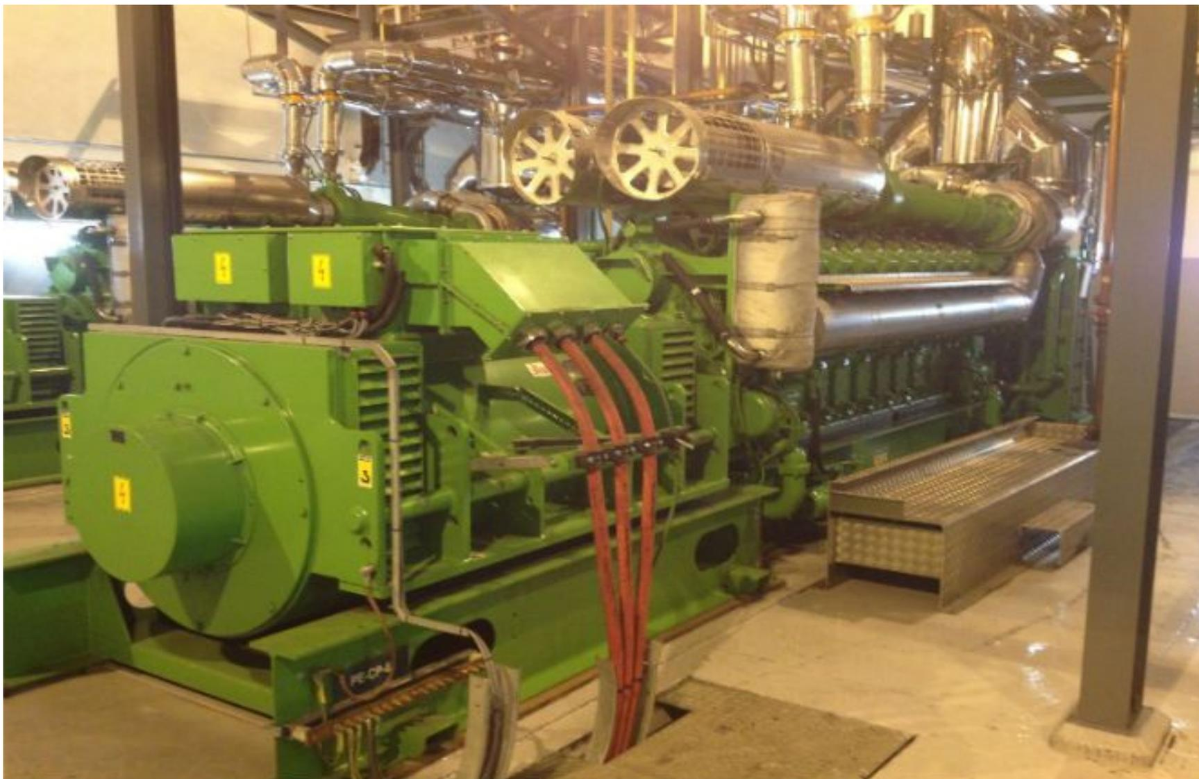
**«RONOX Namaqua Sands», ЮАР – газообразные отходы доменного и титанового производства (8 газовых двигателей JMS620 GS-SL, общая мощность -13,6 МВт)**
