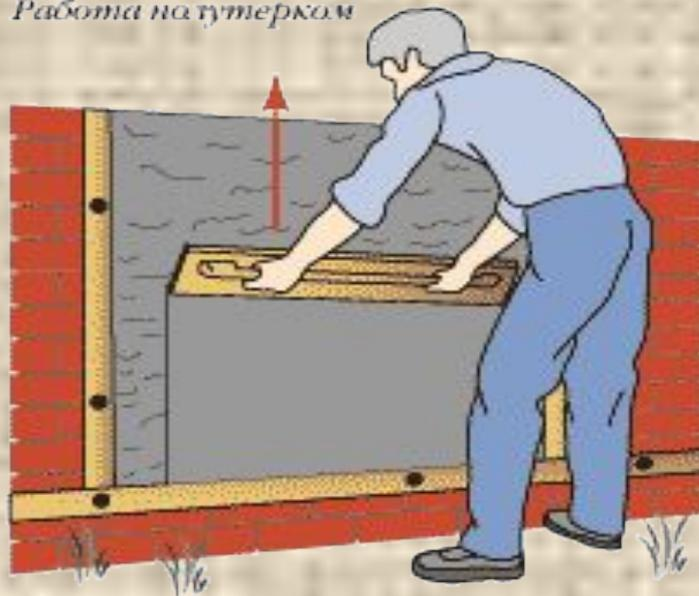
Грунт разравнивают сглаживанием или срезыванием. Заполнив пространство между маяками, следует разровнять раствор полутерком. Следите за тем, чтобы в растворе не оставалось пузырьков воздуха и покрытие плотно прилегло к стене. Движения полутерка могут быть зигзагообразные: короткие — слева направо и справа налево, длинное — вверх и немного в сторону.
