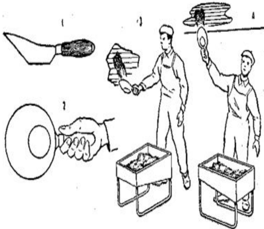
Обрызг делают жидким, как кефир, раствором, нанося его на стену штукатурным ковшом или мастерком, им зачерпывают раствор из ведра и накидывают на стену. Обрызг следует обязательно набрасывать, но здесь нужен навык. В пинг-понг играли? При набрасывании раствора на стену кистевое движение руки примерно такое же, как при игре в настольный теннис.
