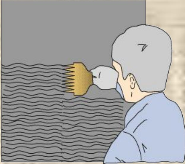
При толщине накрывочного слоя более 5 мм поверхность грунта нарезают волнообразными бороздами.
