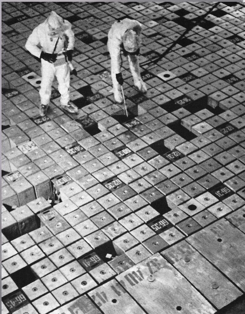
1 час 20 минут (примерно – по математической модели) – стержни автоматического регулирования (АР) вышли из активной зоны на верхние концевики, и оператор даже помогал этому с помощью ручного управления. Только так удалось удержать мощность аппарата на уровне 200 МВт (тепловых). Но какой ценой? Ценой нарушения строжайшего запрета работать на реакторе без определённого запаса стержней – поглотителей нейтронов.
