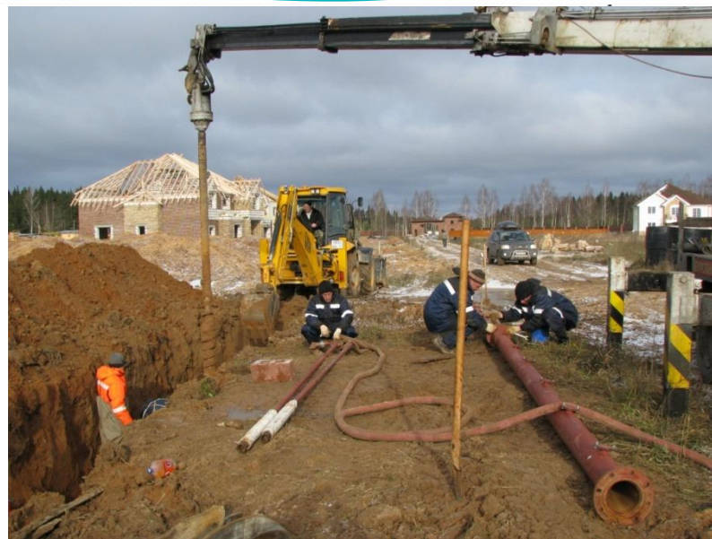
Рис. 25. Водопонижительные скважины:
