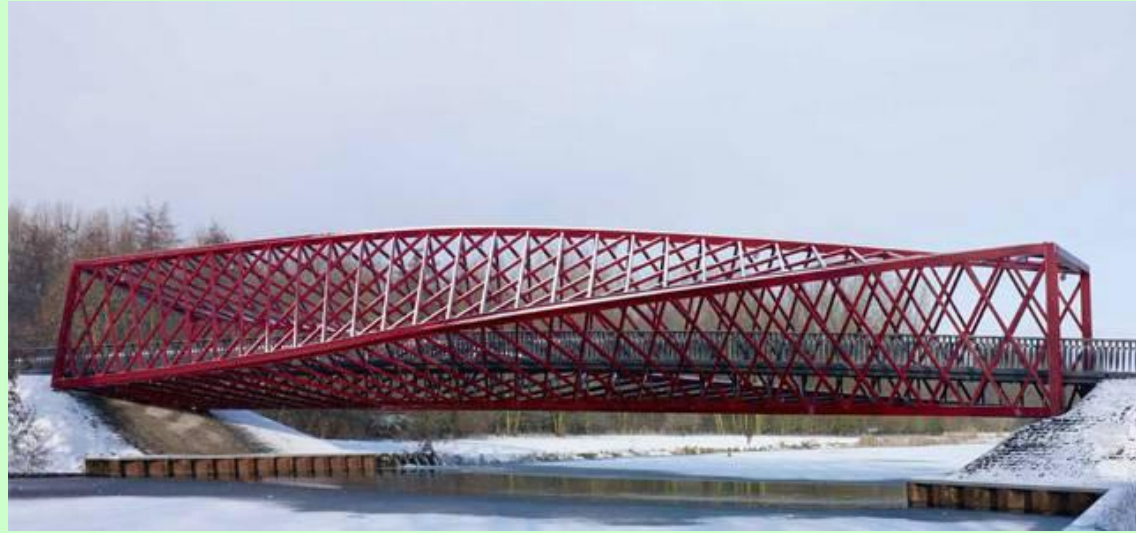
«Покосившийся мост» в Голландии (огибающая мост конструкция сделана намеренно покосившейся, сам мост идеально ровный)
