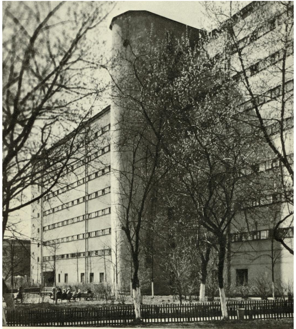
97. Дом-коммуна на улице Орджоникидзе. 1929. И. С. Николаев. Представляет собою комплекс из двух корпусов, соединенных переходом. Его объемно-пространственное построение с сочетанием разновысоких объемов корпусов давало новый подход к решению жилых и общественных зданий, получивший развитие в 1960-е годы.
