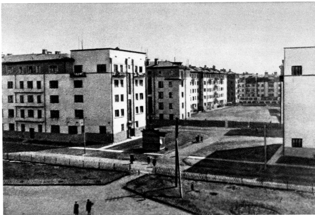
95. Жилой комплекс на улице Усачева. 1926–1927. А. И. Мешков, инженер Г. Масленников и другие. В планировке комплекса наблюдается, с одной стороны, обращение к привычной периметральной застройке кварталов, с другой – стремление ввести свет, воздух, зелень внутрь кварталов, что достигается широкими разрывами между корпусами, обильным озеленением дворов.
